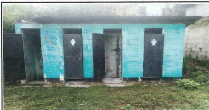
Foto 5: Instalaciones sanitarias que no reúnen las condiciones necesarias para ser utilizadas. Necesitan una pintada en su totalidad y reparación de puertas
