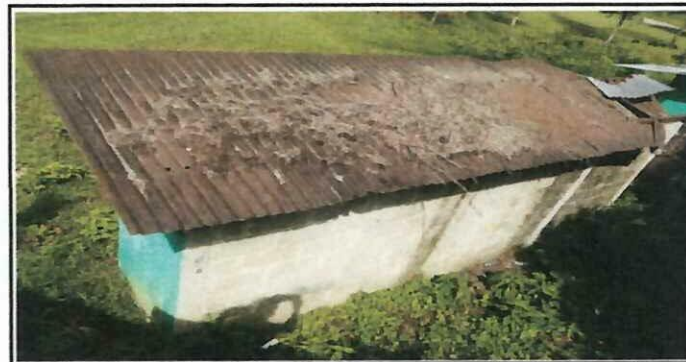
Foto 6: Letrinas de fosa séptica. Necesitan una reparación mínima, no aptas para ser utilizadas, presentan algún peligro. Necesita reparación en el techo.
